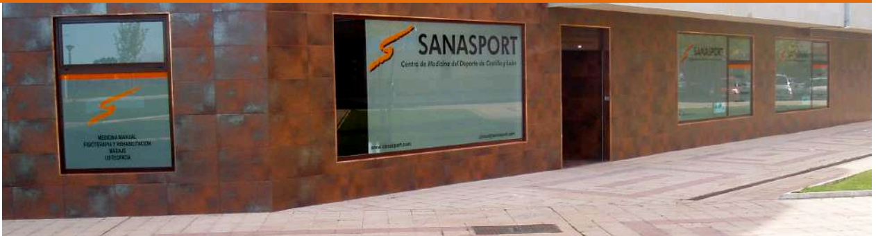
FACHADA PRINCIPAL A AVDA DE NOCEDO N° 96
